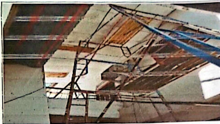
Perbaikan Atap dan Plafon luar
